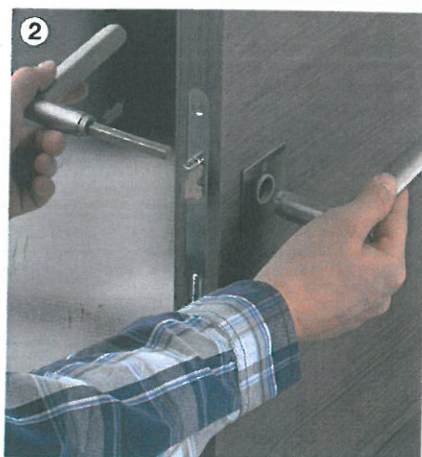
2 Insérer les poignées de porte et assembler
